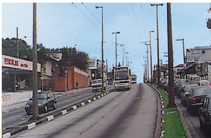
O corredor São Mateus-Jabaquara tem atualmente 33 km de extensão, com 30 km de vias totalmente segregadas do restante do tráfego
